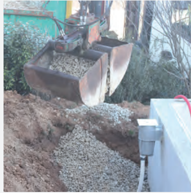
8 Remblaiement des parois
