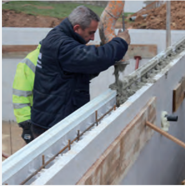
7 Coulage du béton
