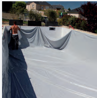
11 Mise en place du liner
