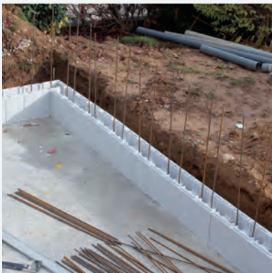
4 Montage des blocs
