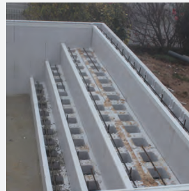
6 Montage de l'escalier
