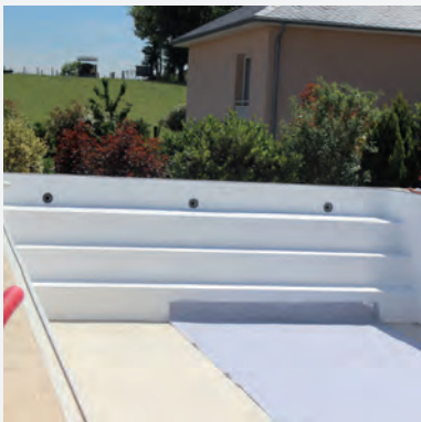
10 Mise en place du feutre
