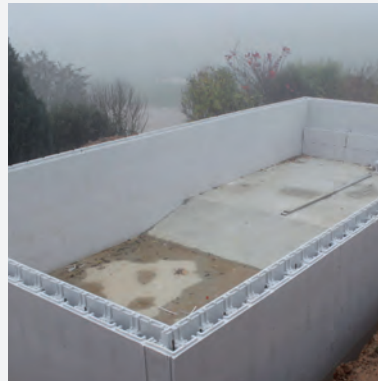
5 Montage de la structure
