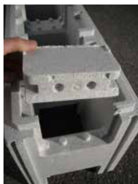
Bouchon haut avant mise en place
