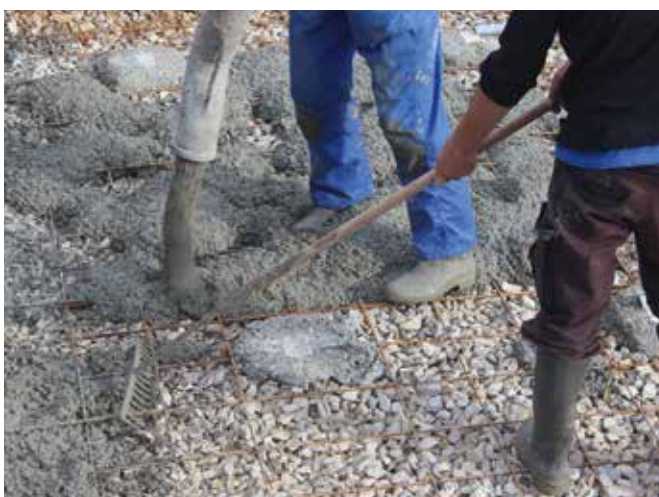
Coulage fond plat
